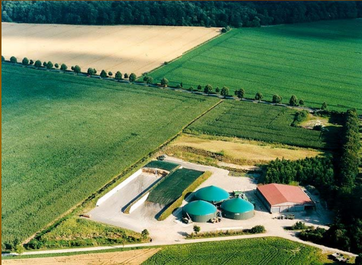
Biogasanlage in Gehrden/Lenthe
